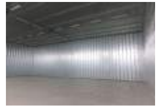
◎冷凍庫の内張りにも
