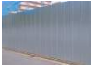
◎建設現場にて
