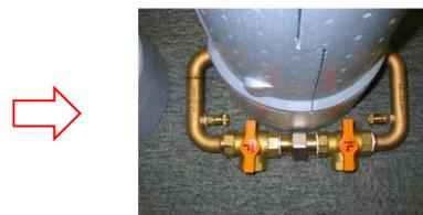
三方弁を、垂直(浄水)に切替える。
