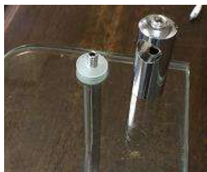
四、シリコンパッキンをガラスカウンター上部より入れ、アルミバー受けナットで挟み込み固定
