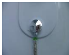
給水口にシャワーホースを接続
