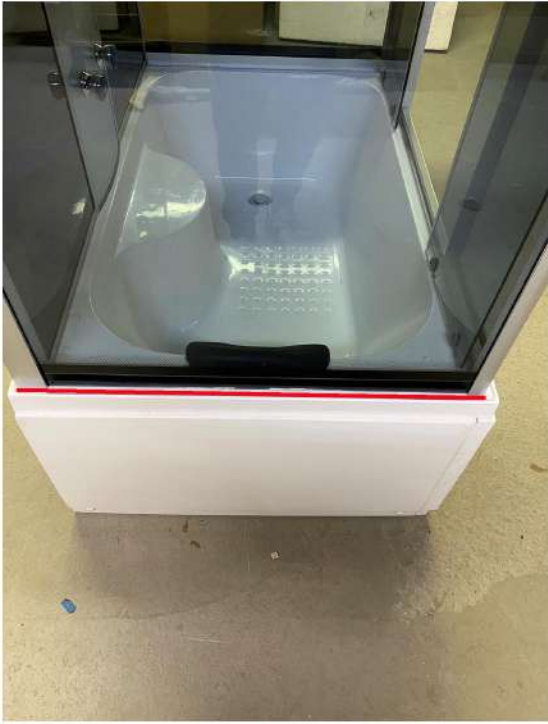
外側両サイド下部 床パネル水返しとガラスフレームの間を埋めて下さい
